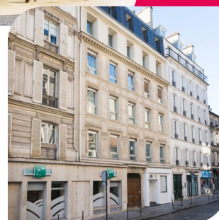
Investissement déjà réalisé : Immeuble Berryer, 75008 Paris**
