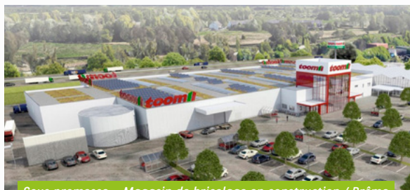
Sous promesse - Magasin de bricolage en construction / Brême
