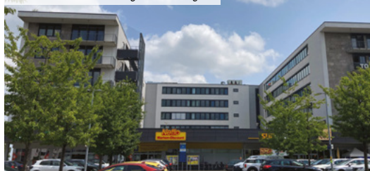
2-6 Ulmer Strasse - Stuttgart - Allemagne
