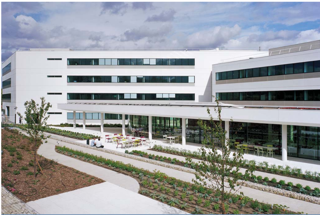
Immeuble « Canopée » - Rue de la Redoute - Guyancourt (78)
