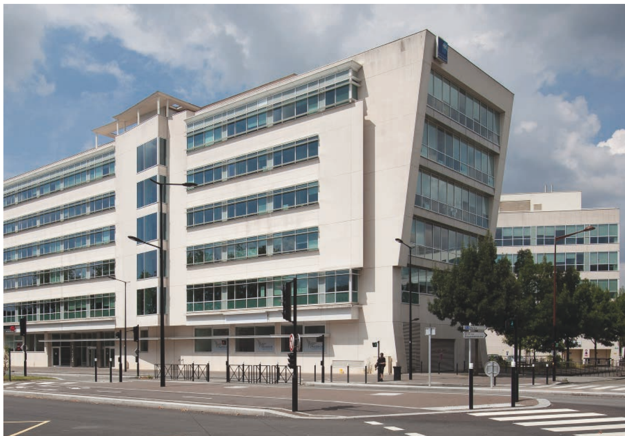
Immeuble Le Futura - Place Wicklow - Montigny-Le-Bretonneux (78) Locataires principaux : Informatique Banque Populaire et BNP Paribas
