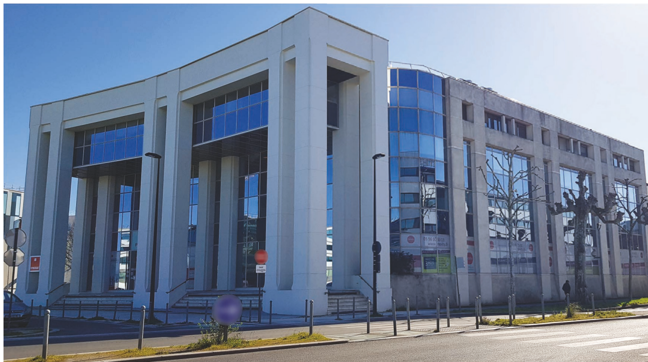
Cours du Médoc - Bordeaux (33) Locataire principal : Nexity
