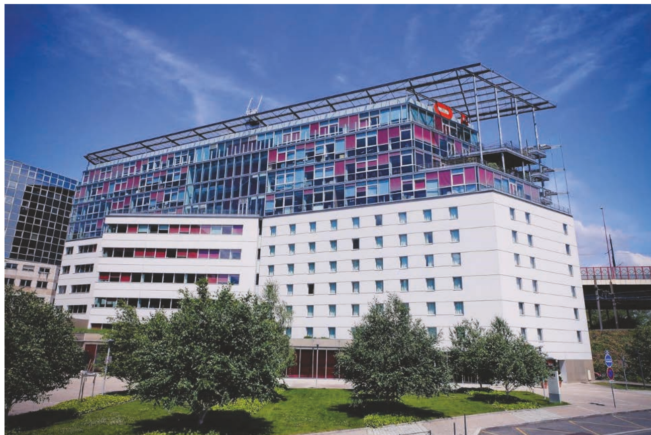
Immeuble « Saint Clair » - 5/7 avenue de Poumeyrol - Caluire et Cuire (69) Locataires : Cabot Financial France et Transdev
