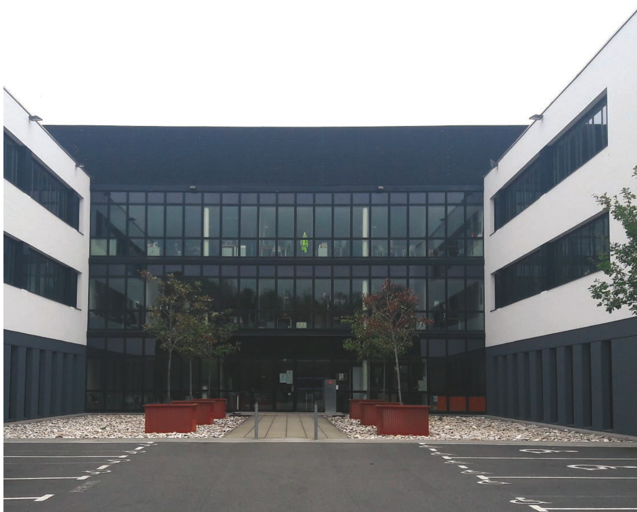
Immeuble « Métropolis IV » - Rue du Patis Tatelin - Rennes (35) Locataire : Orange
