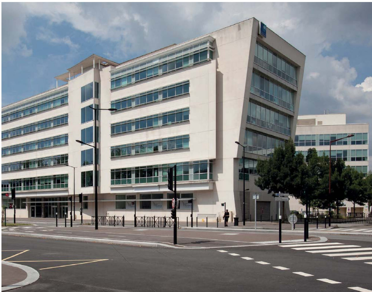
Immeuble Le Futura - Place Wicklow - Montigny-Le-Bretonneux (78) Locataires principaux : Informatique Banque Populaire et BNP PARIBAS
