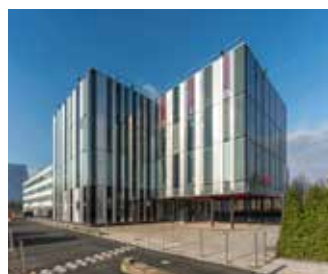
Geodis/Locked-up/Grenke/Ciamt Carré Sénart - Lieusaint
