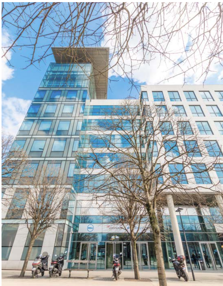
Les Portes de France – Saint-Denis (93) Acquisition 2015
