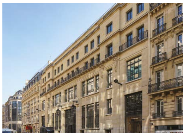
49-51, rue La Boétie - Paris (75008) (Prise en charge de travaux preneur (mobilier + moquette))
